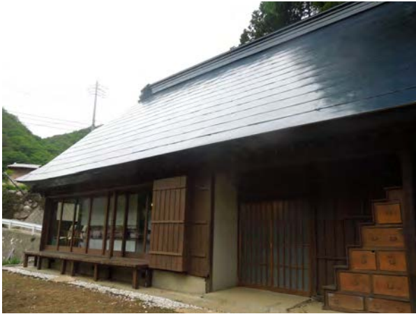
▲築100年を超える古民家をリノベーション
