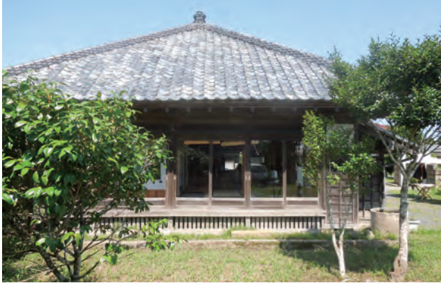
▲施設内の建物の外観デザイン
